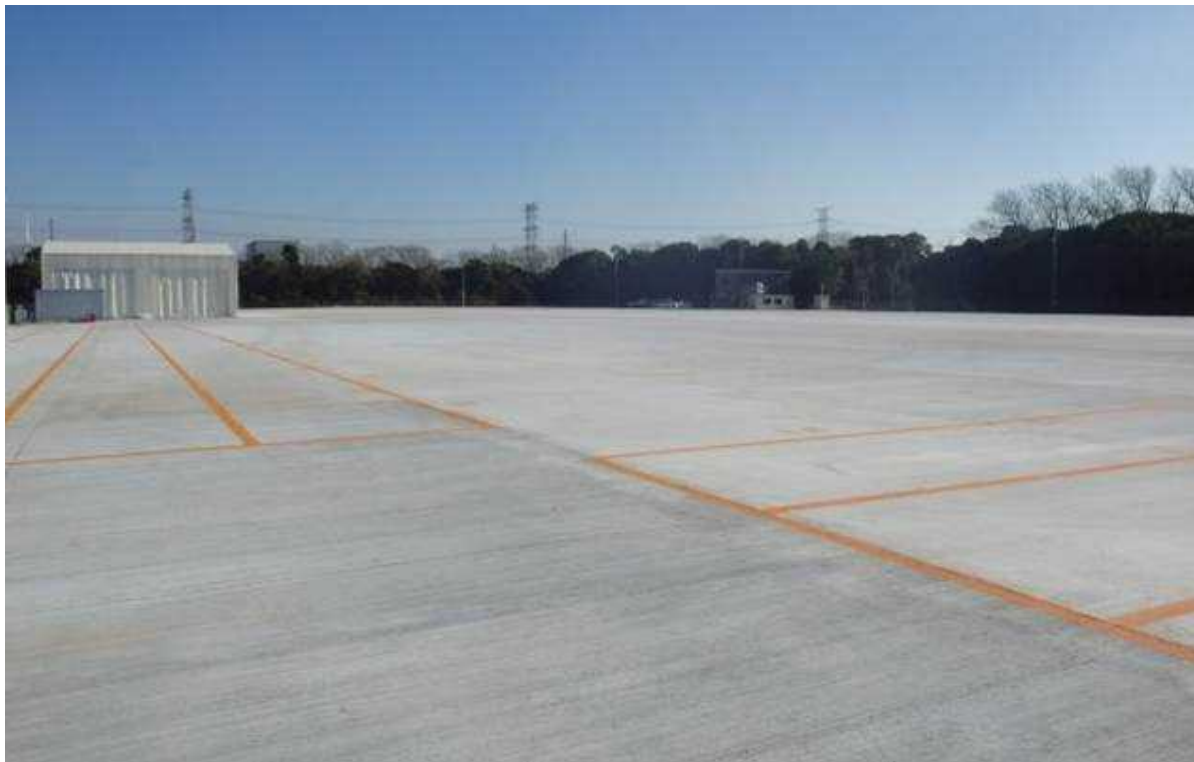
(袖ヶ浦バルクコンテナセンター 広い敷地内にコンテナを屋外保管する。写真左奥は作業用テント。)
