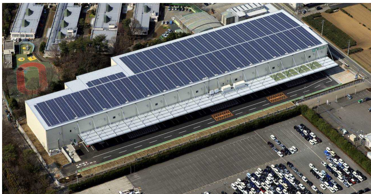
(屋上の太陽光パネル)
